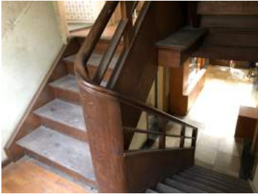
Treppe zum 1. OG, links Zimmer 1 , April 2024
